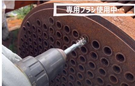
【C&W メカニカルプラグ】 第1弾：熱交換器への打設前の準備編
